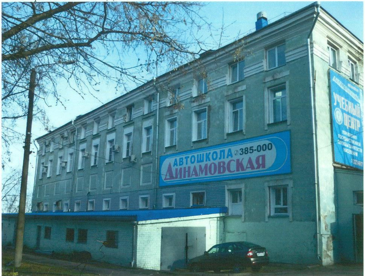
Фото 3. «Архитектурный комплекс: 2 здания присутственных мест», Кировская область, г. Киров, Динамовский проезд, д. 2. Фото Брызгалов Ю.П. Дата – 25.04.2016.
